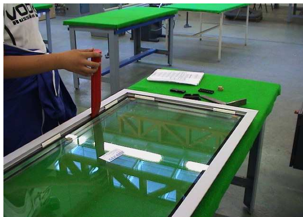
Vitrage d'une fenêtre en aluminium
